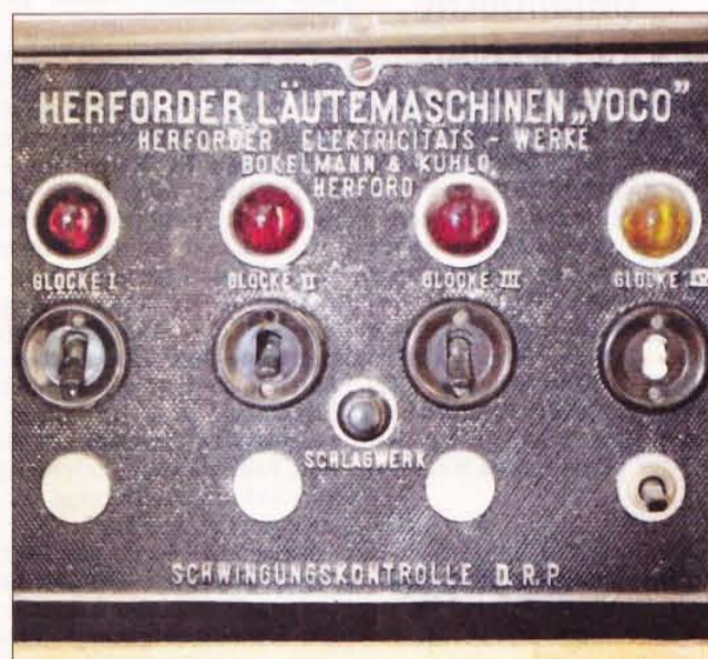
Die Schalter für die vier Glocken der alten Kreuzkirche befinden sich im ehemaligen Haupt-Kirchenraum, dem späteren Gemeindesaal.
